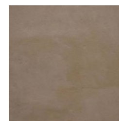
Enduit lissé à la truëlle
