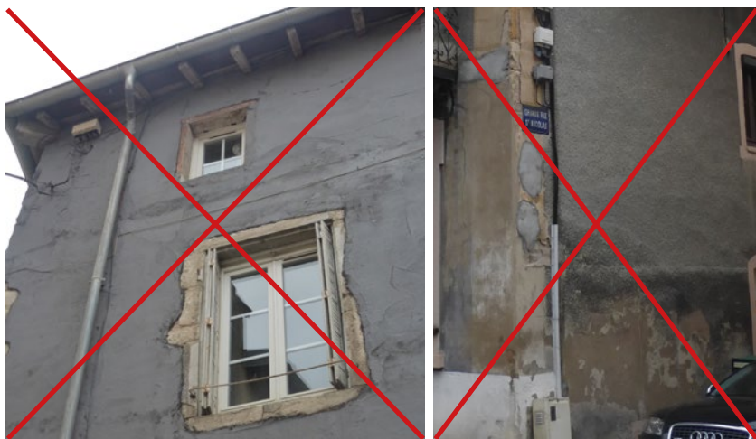
L'usage du ciment (enduits, joints) est totalement proscrit sur les constructions en moellons de pierre, car il peut provoquer d'importantes altérations du bâti.
