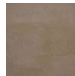
Enduit lissé à la truelle
