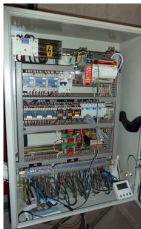
Armoire CTA équipée d'un automate Trend IQ422
