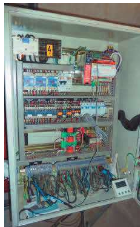
Armoire CTA équipée d'un automate Trend IQ422
